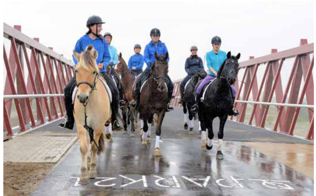
Brug voor ruiters, fietsers en wandelaars over de N205
