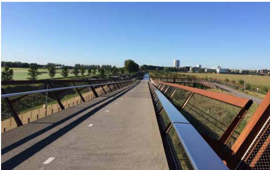
Fietsbrug in de Geniedijk over de rijksweg A4
