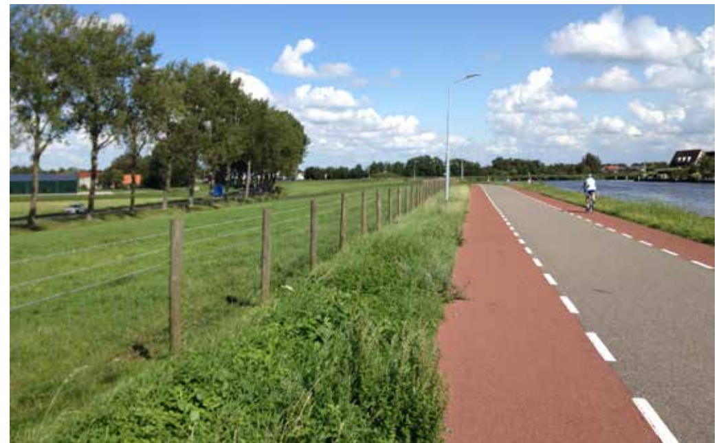
Ringdijk bij Weteringbrug
